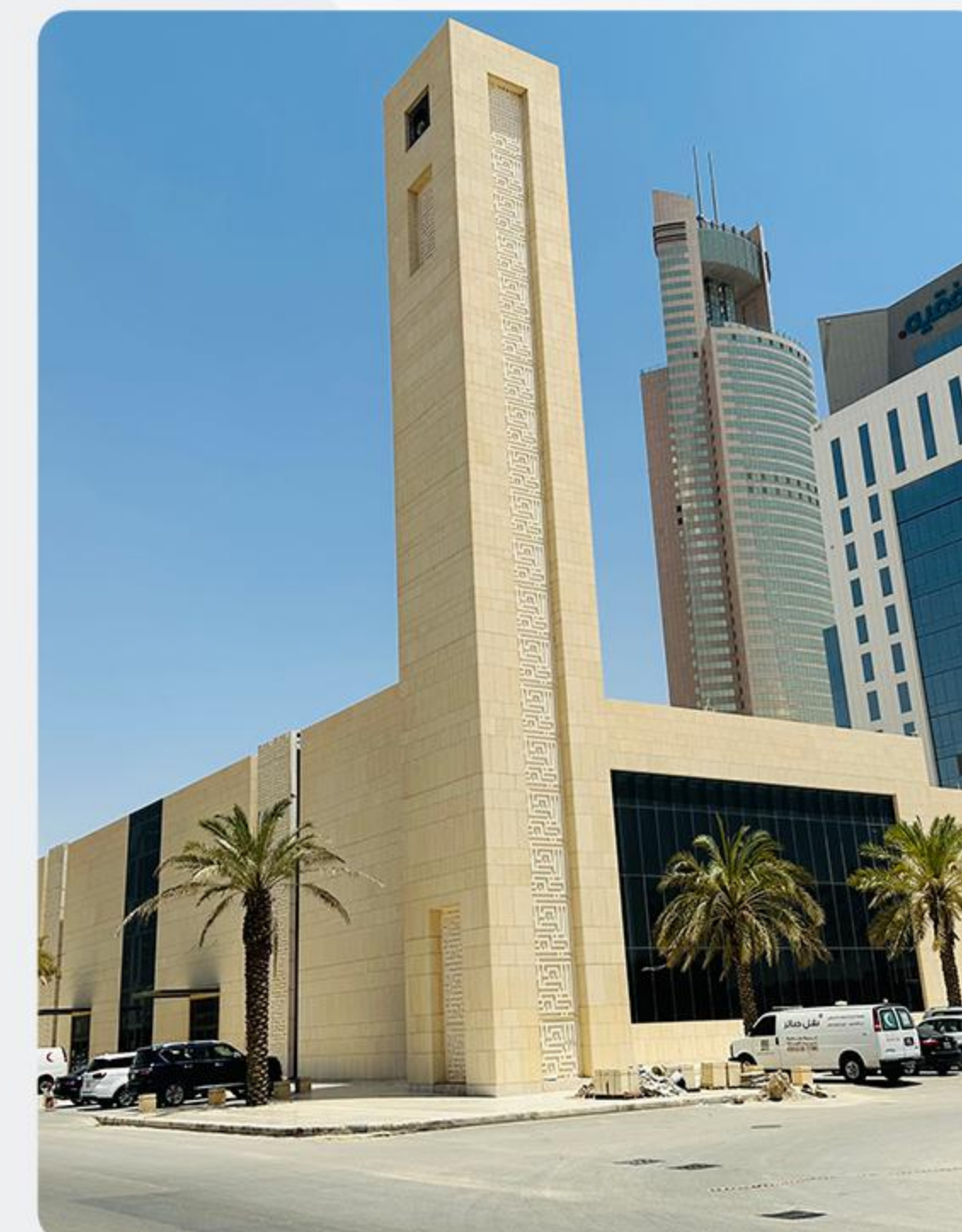
توريد و تركيب حجر طبيعي مسجد البابطين - حي الصحافة - الرياض.
