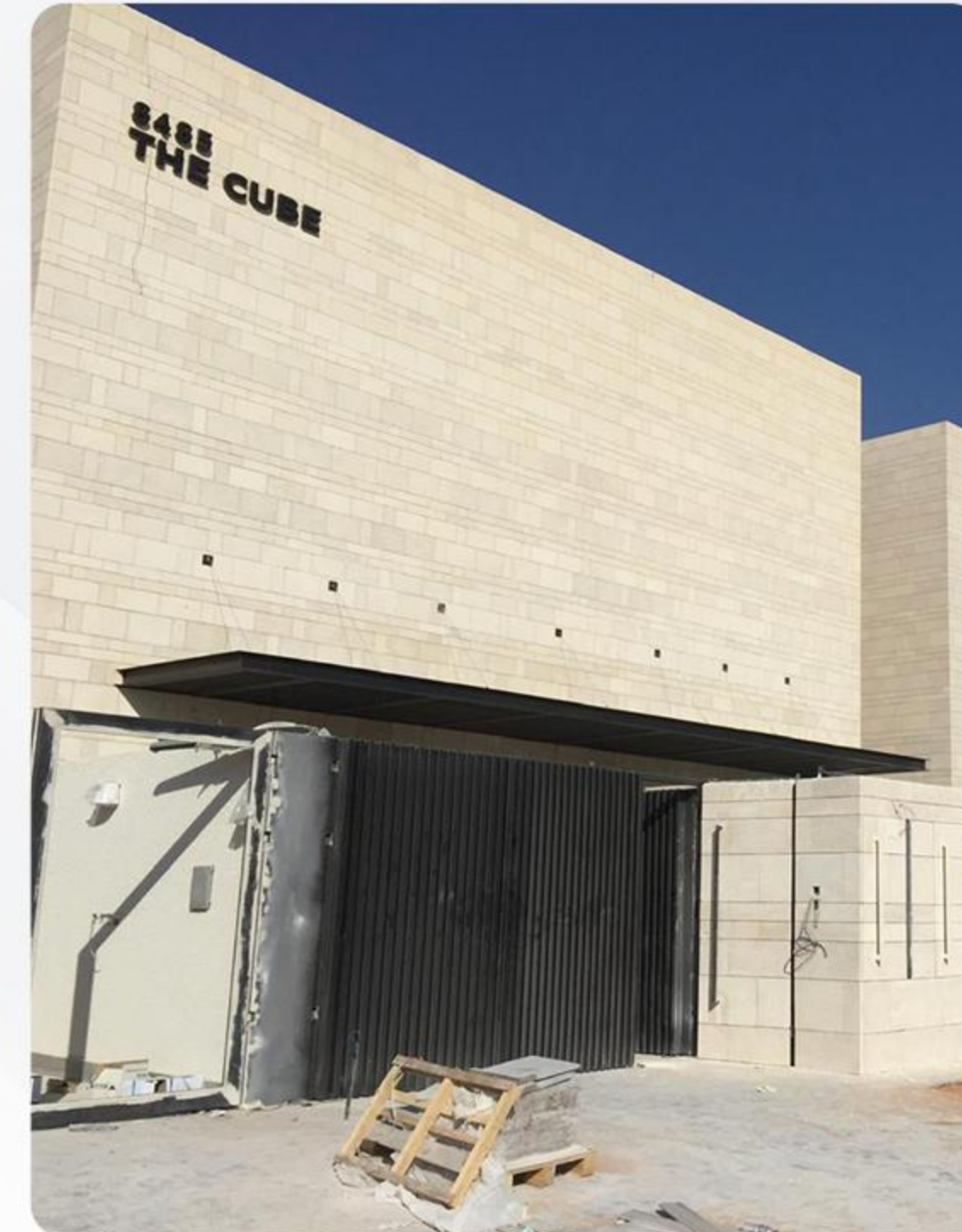
توريد وتركيب حجر طبيعي مشروع مجمع سكني 28 فيلا شركة الراجحي للتجارة والصناعة - حي الملقا - الرياض.
